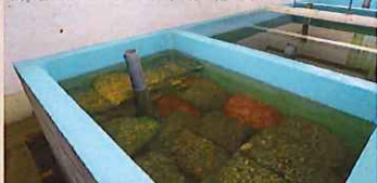
隣の部屋にはコンクリート製の濾過槽を設けた
